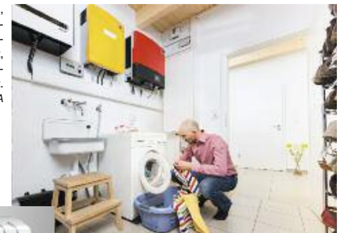
Batteriespeicher mit den als überaus sicher geltenden Lithium-Eisenphosphat-Zellen: Eine Notstromfunktion, mit der die Batterie bei Stromausfall automatisch die Versorgung im Haus übernimmt, kann nachgerüstet werden. Vaillant
