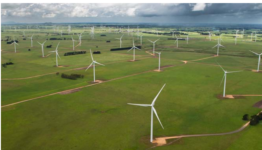
Mit Hilfe von Algorithmen kann Vestas berechnen, ob ein Standort sich für den Bau von Windkraftanlagen eignet. Foto: Vestas
